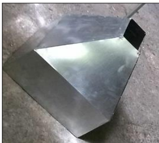
Fig. 2 Corte y doblaje ducto salida.
