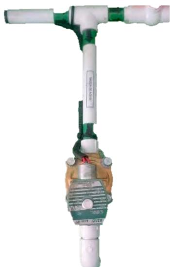
Fig. 9 Electroválvula controladora del paso del aceite al tanque de recolección.
