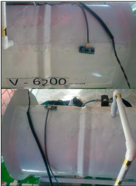
Fig. 8 Adaptación del sensor ultrasónico en la parte externa de la vasija del separador de producción trifásico, compartimiento del aceite.
