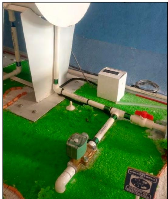
Fig. 10 Ducto de evacuación de aceite realizado en tubería PVC de ½ pulgada.
