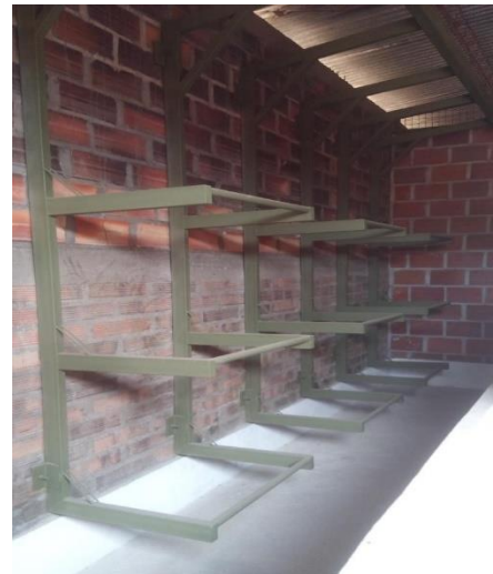
Fig 4. Estructura metálica del cuarto de lubricantes.
